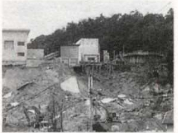
立入禁止(大きく陥没)
